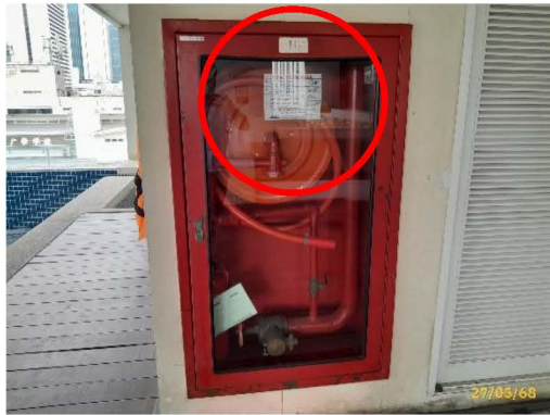
ป้ายแนะนำการใช้อุปกรณ์ในระบบป้องกันและระงับอัคคีภัย
